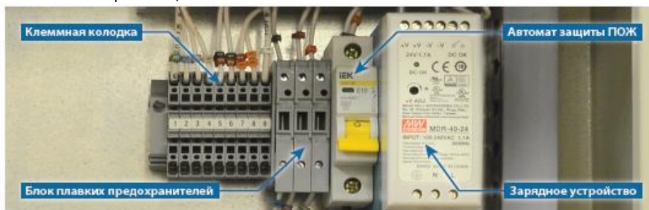
Устройство шкафа АВР
