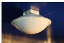
9) **Система автоматического пожаротушения** предназначена для локализации и тушения горючих жидкостей и электрооборудования, находящегося под напряжением. Срабатывает самостоятельно, при достижении температуры 85°C.
