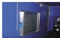
2) **Автоматический привод системы вентиляции** включает в себя впускной и выпускной клапаны с 2-х или 3-х позиционными автоматическими приводами.
