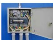
8) **Вводно-распределительное устройство** предназначено для коммутации внешней нагрузки с фидером внешней сети или с ДГУ в блок-контейнере через автоматические выключатели.
