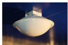
10) **Система автоматического пожаротушения** предназначена для локализации и тушения горючих жидкостей и электрооборудования, находящегося под напряжением. Срабатывает самостоятельно, при достижении температуры 85°C.
